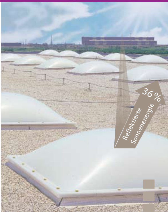
Hallenverglasung mit doppelschaligen Lichtkuppeln.
